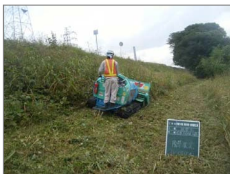
堤防法面管理(除草)
