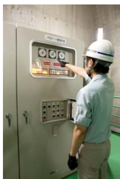
機械設備、 電気設備等の点検
