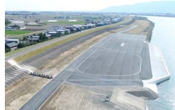
船 長良川防災船着場 (平成31年3月完成)
