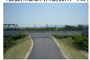
開 木曽川右岸緊急開口部 (平成30年3月完成)
