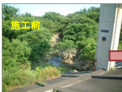
河道内樹木の伐開
