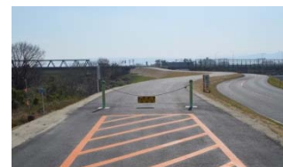
開 木曽川右岸緊急開口部 (平成30年3月完成)
