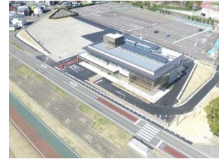
ST 岐阜防災ST (長良川岐阜河川防災ステーション)
