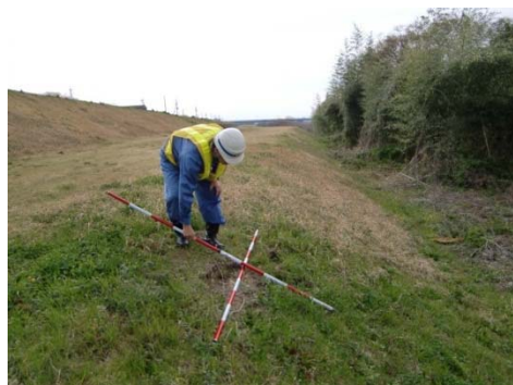
河川巡視状況
