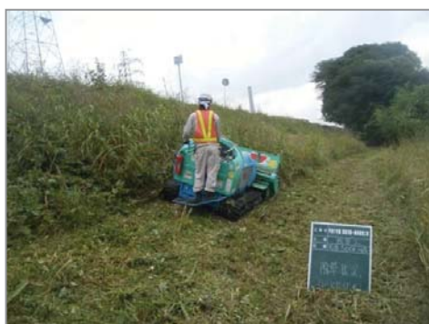
堤防法面管理(除草)
