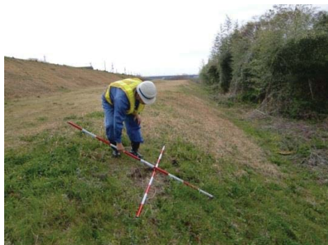
河川巡視状況
