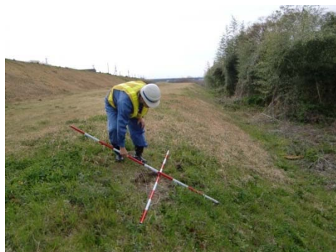
河川巡視状況
