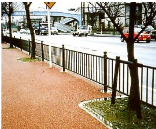
写真-3.5.3 透水性舗装の整備例
