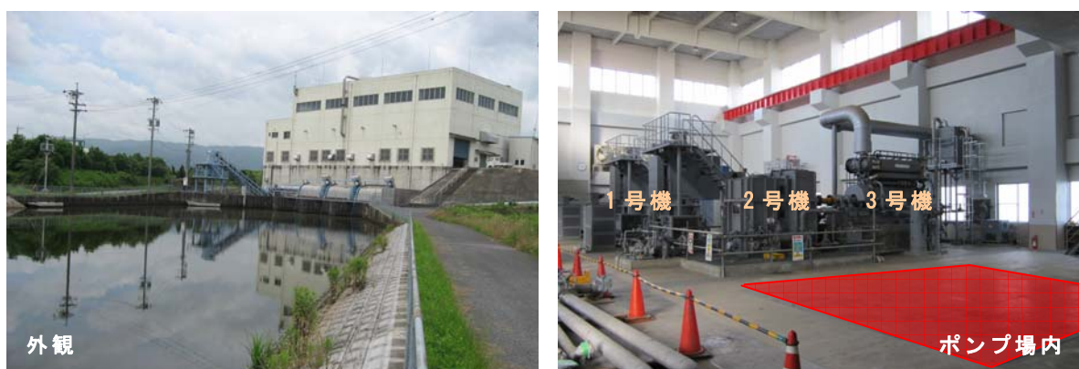
写真-3.5.1 福東排水機場
