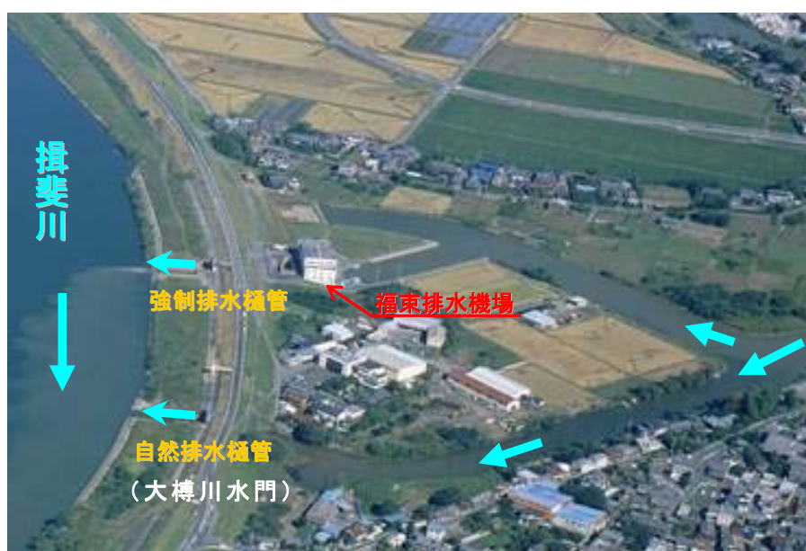
図-3.5.1 福東排水機場の位置
