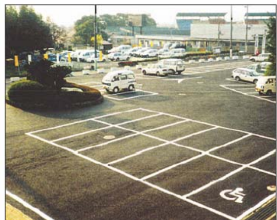
写真-3.5.3 透水性舗装の整備例
