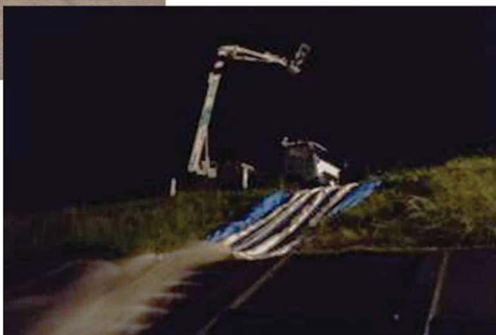
平成23年9月台風15号における排水ポンプ車、照明車の作業状況
