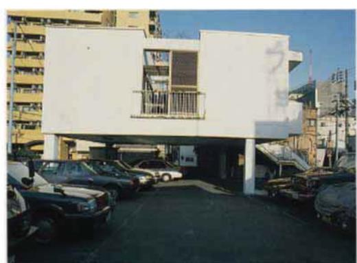
▲鶴見川の近くに住んでいるため過去の経験を生かし、洪水時に被害がないようピロティ構造とした
