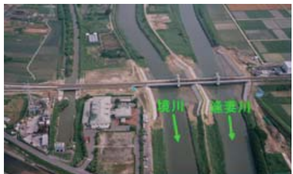
橋梁掛け替え（愛知県）
