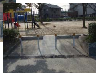
施工事例（大府市）
