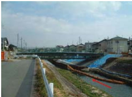
築堤・護岸工（愛知県）
