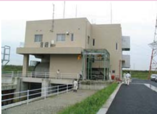
排水機場整備（愛知県）
