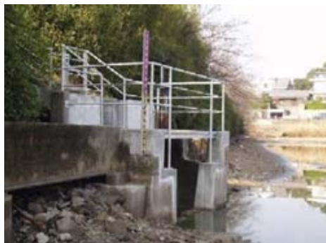
施工事例（大府市）
