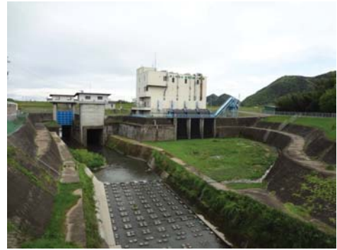
加茂川排水機場 全景
