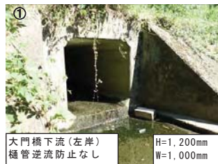
図- 3.6.22 流入下水樋管吐出口
