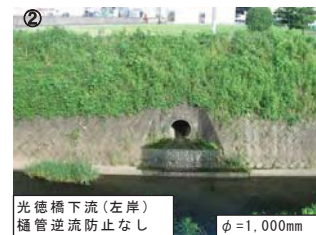
図- 3.6.22 流入下水樋管吐出口
