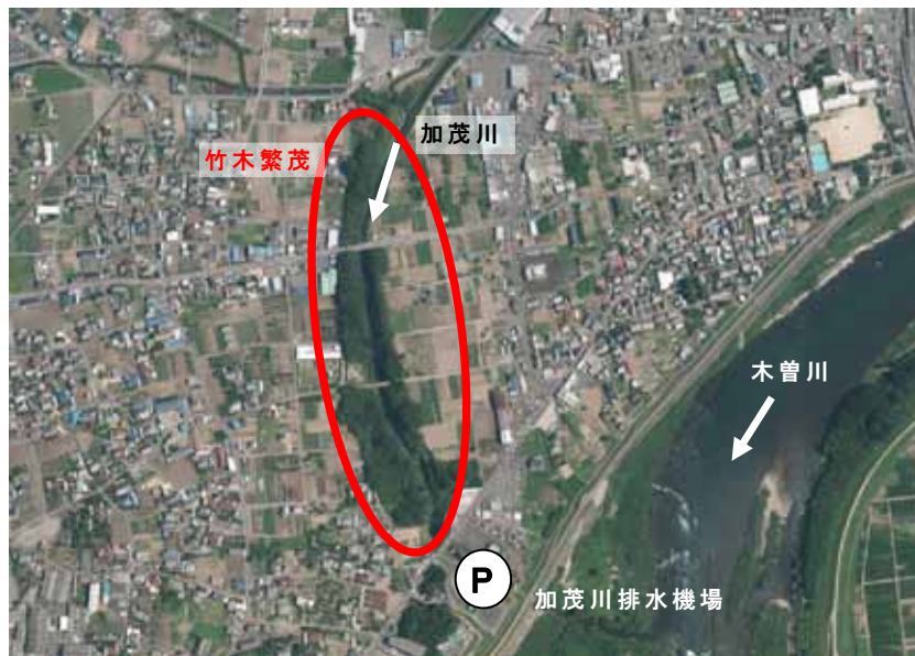
図- 3.6.20 加茂川下流部の竹木繁茂状況
