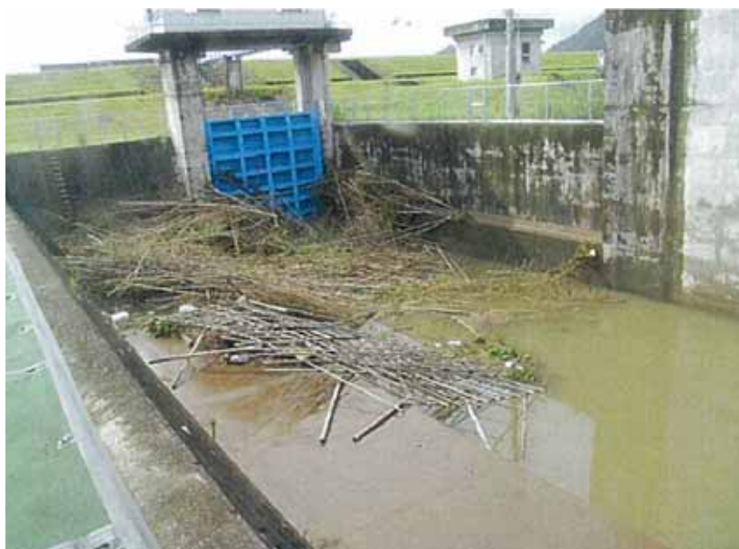
図- 3.6.21 出水後の加茂川排水機場樋門の状況
