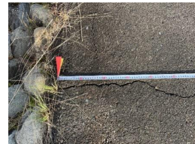
クラック発生状況（右岸堤防天端道路）
