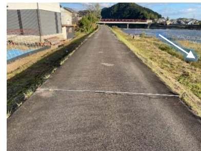
クラック発生状況（右岸堤防天端道路）
