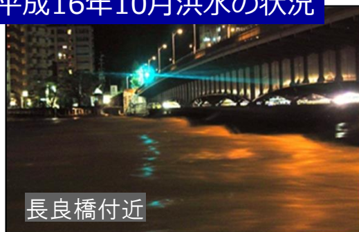
平成16年10月洪水の状況
