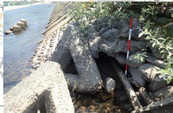
護岸損傷
