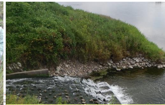
護岸損傷
