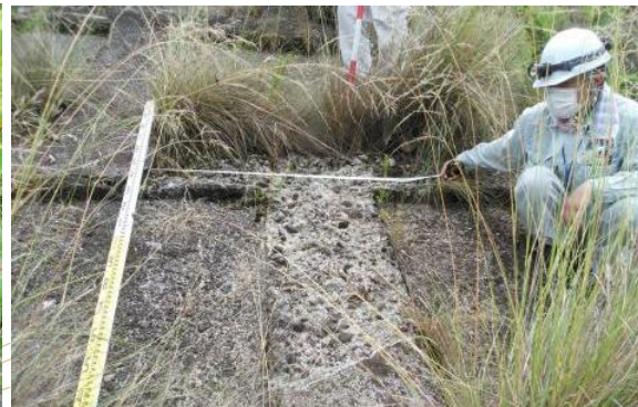
護岸損傷
