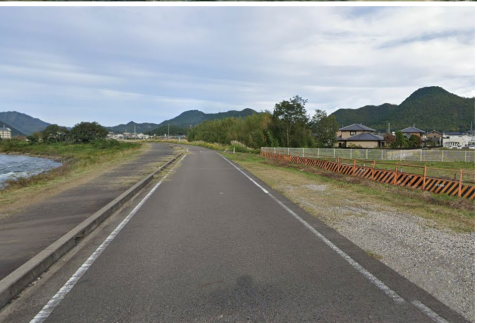
写真① 72.2k付近左岸堤防川裏状況
