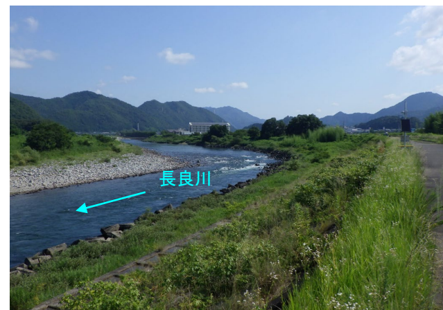
写真① 72.0k付近より上流を望む
