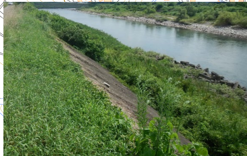
コンクリート吹きつけ補修
