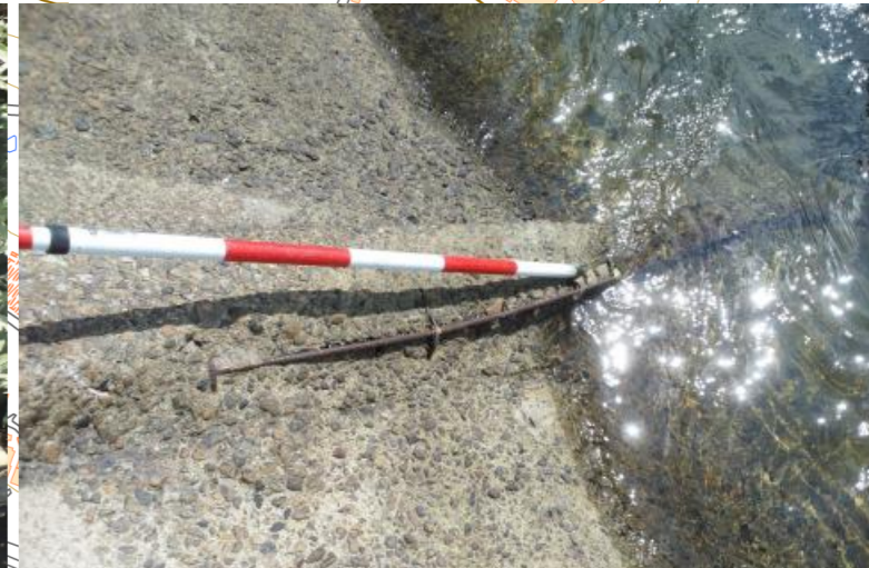
護岸損傷
