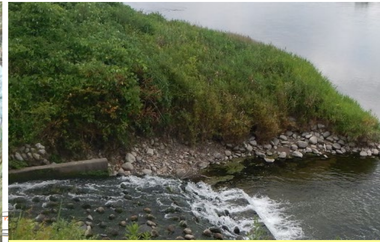
護岸損傷
