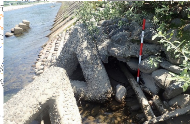
護岸損傷
