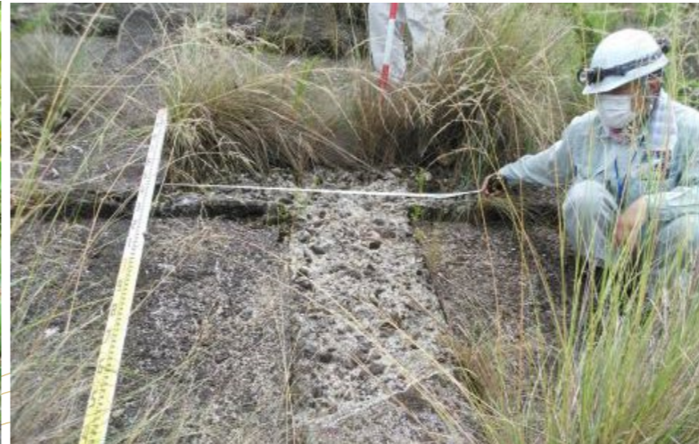
護岸損傷
