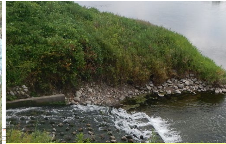
護岸損傷
