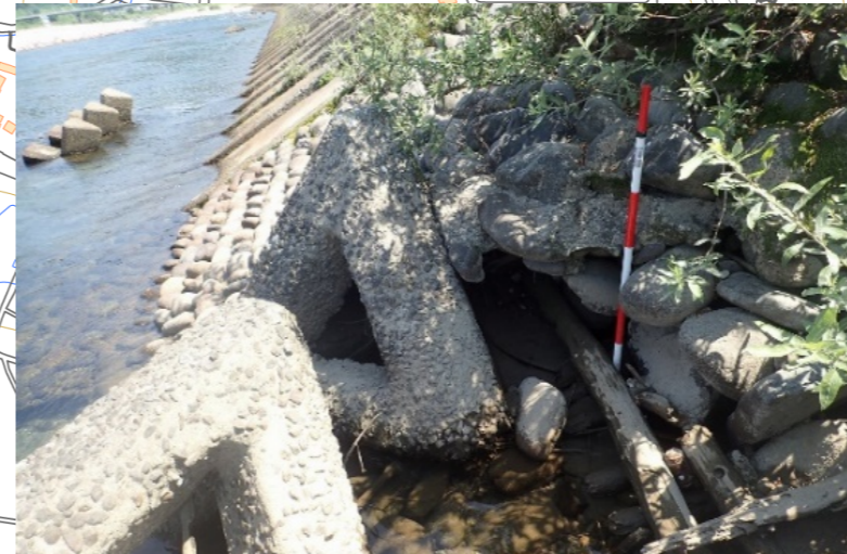
護岸損傷
