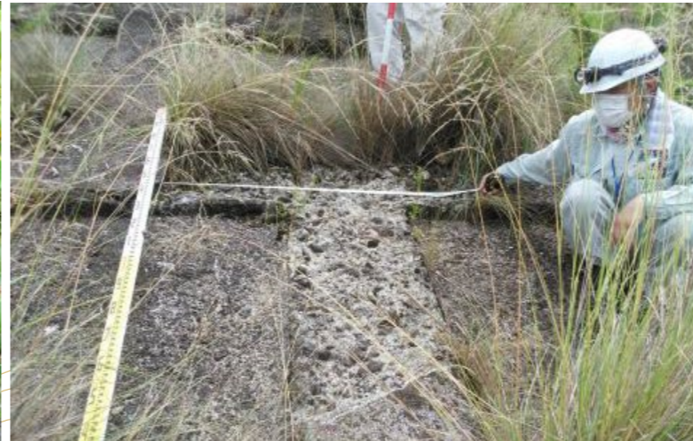
護岸損傷
