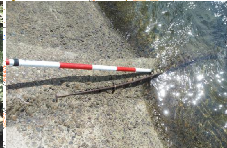
護岸損傷
