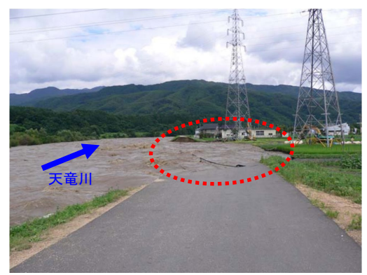
天竜川 護岸の侵食 (長野県上伊那郡箕輪町)
