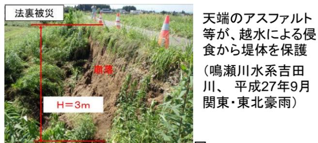
天端のアスファルト等が、越水による侵食から堤体を保護
