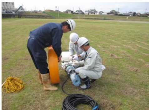
排水ポンプの組立て
