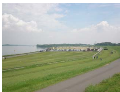
下流より上流を望む
