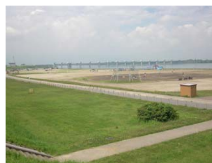
上流より下流を望む
