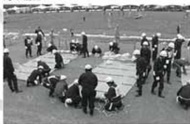
シート張り工
