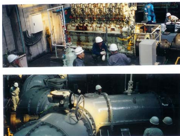
排水（試運転）状況
