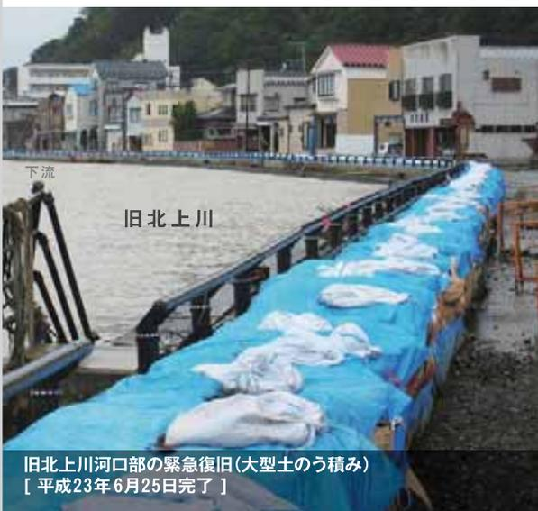
旧北上川河口部の緊急復旧(大型土のう積み)
