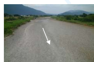
牧田川高橋付近の瀬切れ(10.2k付近)
