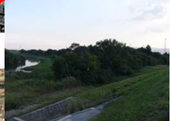
旧流路のある河川敷 (下流側)
