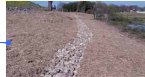
浸透溝を設置 (H22.4)
