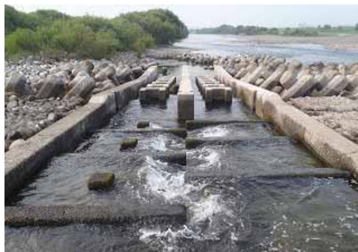
揖斐川第5床固 (アイスハーバー式魚道)
