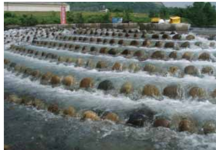
根尾川第4床固 (棚田式魚道)
