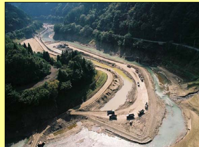
再開発事業による貯水池の掘削状況
