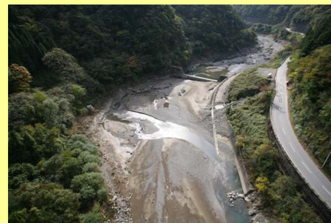
本川貯砂ダムの堆砂状況
