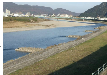
水制工（コンクリートブロック水制）
