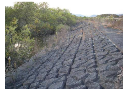
景観護岸（擬石ブロック）
