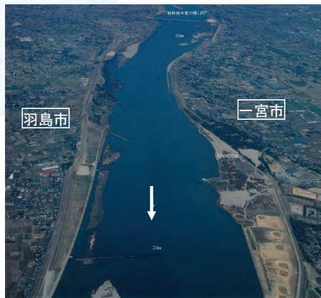
木曽川下流域：木曽川大堰の湛水域 (29.0～31.0km付近)
