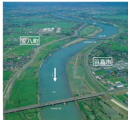
長良川下流域：緩やかな流れ (33.0～36.0km付近)
