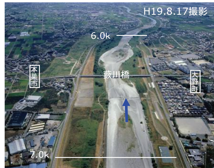
伏没により生じる瀬切れの状況 (根尾川 藪川橋)
