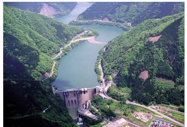
横山ダム(再開発中)
