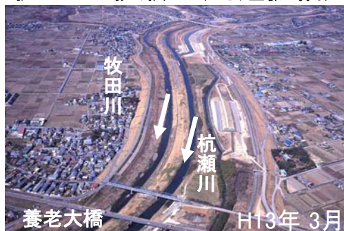
牧田川・杭瀬川(河道拡幅)
