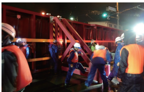
② 長良・大宮陸閘を14年ぶりに閉鎖 (大宮陸閘閉鎖の様子)
