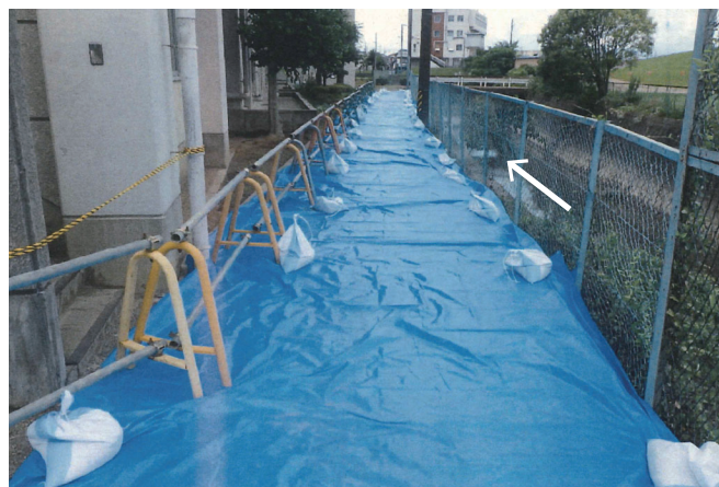
応急工法の完了
