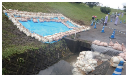
水防工法完了
