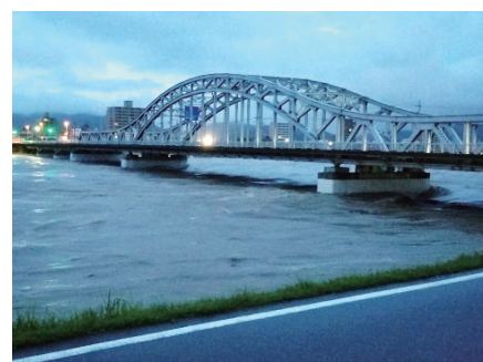
▲ 洪水時の長良川(忠節橋付近)
