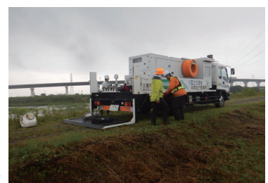
照明車及び排水ポンプ車設置状況(7月6日) ▶
