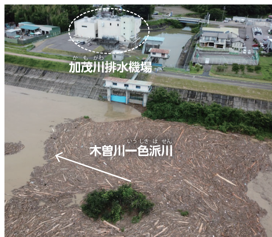
大量の流木(7月8日11時頃) 右岸66.6k(加茂川排水機場)付近
