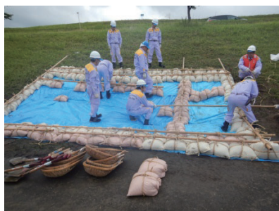
シート張り工法
