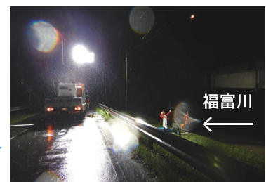
照明車及び排水ポンプ車稼働状況(7月8日) ▶
