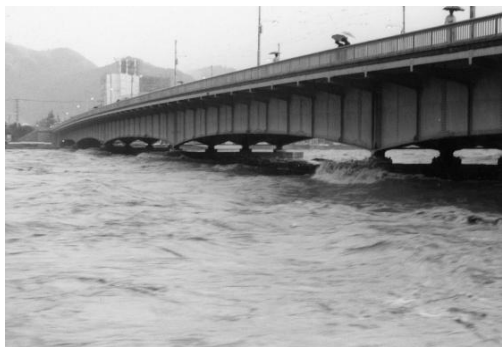
1 長良川の出水状況 長良橋上流側
