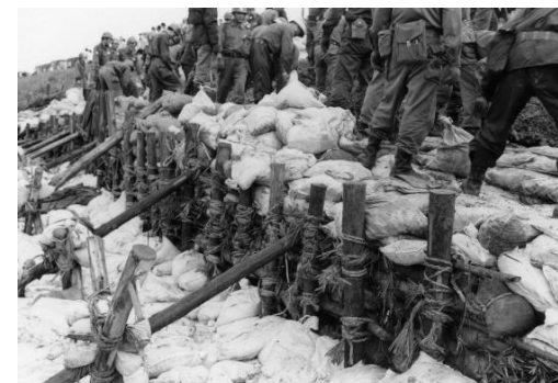
10 自衛隊要請による水防活動状況 伊自 良川左岸則武地
