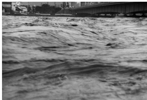
2 長良川の出水状況 長良橋上流側
