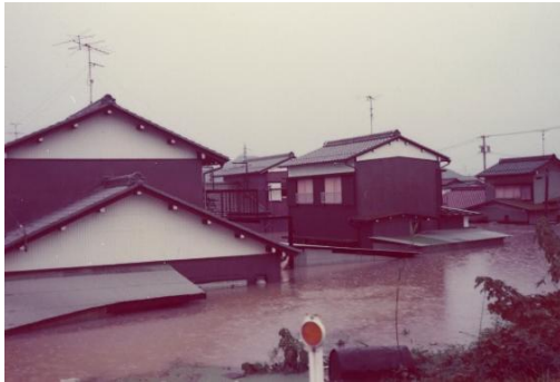
13 伊自良川決壊による蛭川流域の湛水状況
