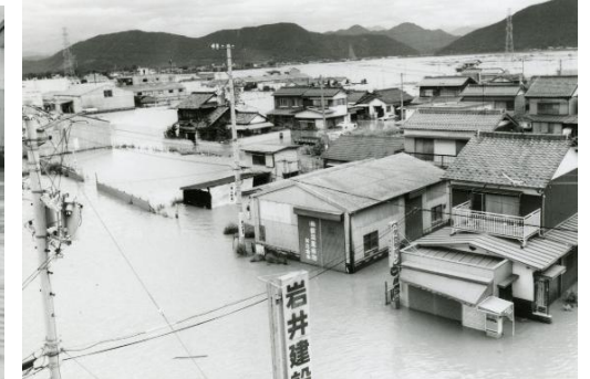
16 県道繰舟橋より西折立地内の湛水状況
