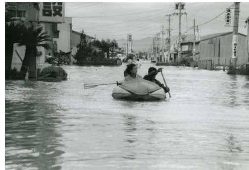
15 県道繰舟橋より西折立地内の湛水状況
