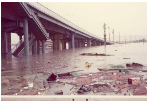
5 菅生地内環状線湛水状況
