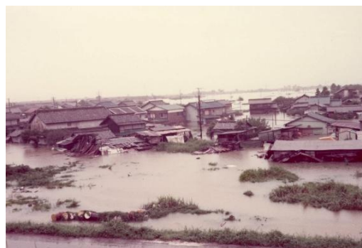
6 島地内湛水状況
