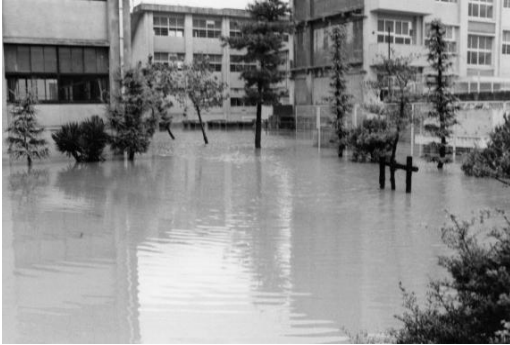
25 早田川下流 島中学校湛水状況
