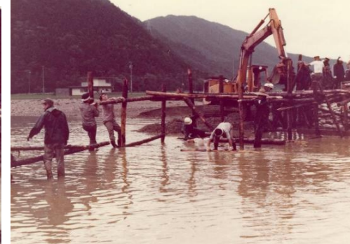
12 決壊口の仮応急工事
