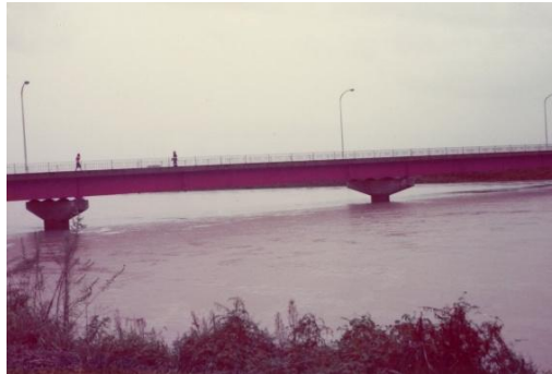
14 伊自良川決壊による蛭川流域の湛水状況
