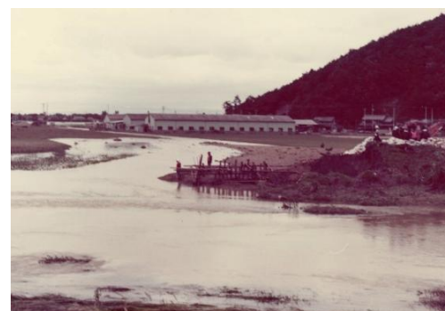
11 伊自良川右岸石谷地内決壊状況
