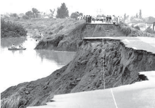
堤防復旧作業＝長良川安八町大森決壊現場
