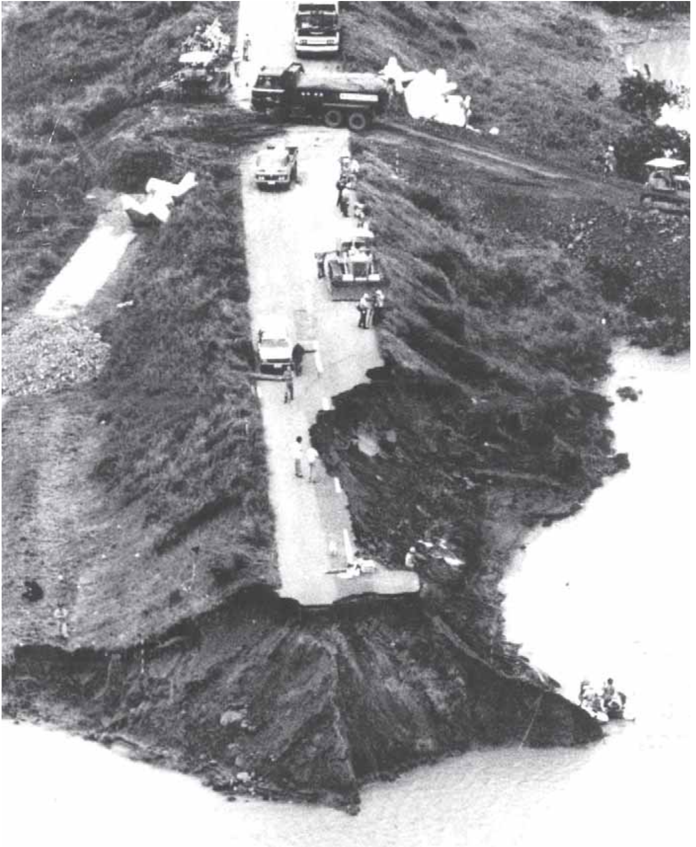
第一歩を踏み出した建設省木曾川上流工事事務所の 長良川右岸決壊現場締め切り作業は徹夜で急ピッチ 9月14日付け岐阜新聞より
