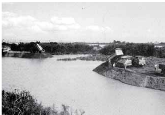
仮締切工事状況(13日)
