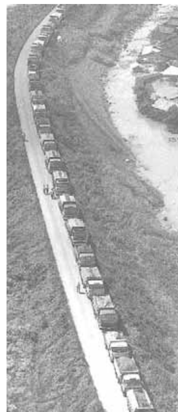
復旧用土砂を運ぶ ダンプカーの行列
