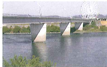
各務原市川島北山町 東海北陸自動車道 高架橋下一帯
