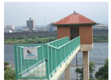
市委託樋管管理業務の土田樋管
