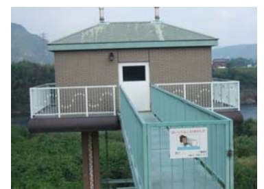
市委託樋管管理業務の下田樋管
