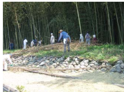
第3回遊歩道周辺の整備作業の様子
