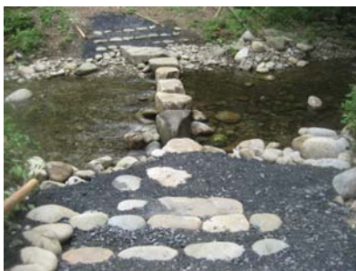
市施工の取付け道路・飛び石設置工事
