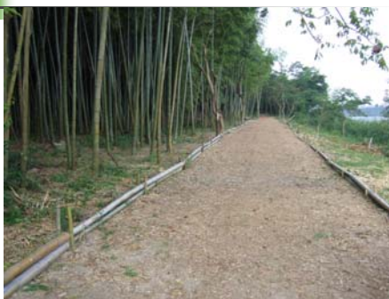
完成した遊歩道(08.4.19)
