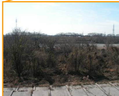
繁茂した樹林 (南派川6km付近)
