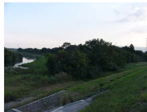
旧流路のある河川敷 (下流側)
