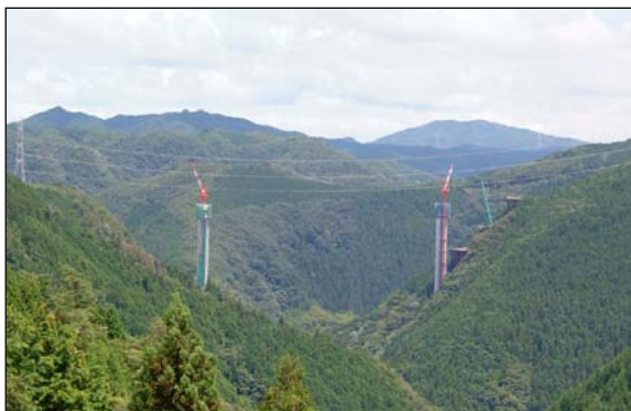
新旅足橋下部工完成 (H19. 2)
