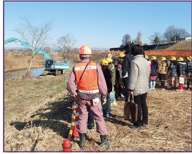
多様な生物のすむワンド環境の整備【国土交通省木曽川上流河川事務所】
