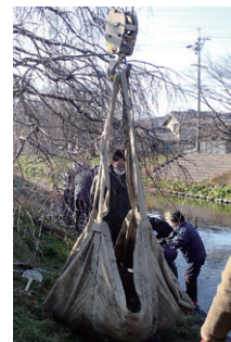
▲左：川底からとれた汚泥。人が小さく見えるくらい大量です。 右：大量の汚泥をクレーンでトラックの荷台へ移動し運びます。
