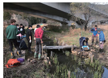
▲小川の河岸の修理。石も土もこの里山から集めてます
