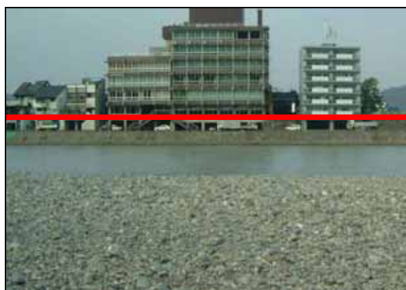
痕跡水位（長良橋右岸上流）
