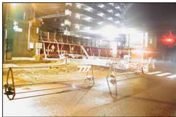
長良陸閘閉鎖状況（長良橋右岸）
