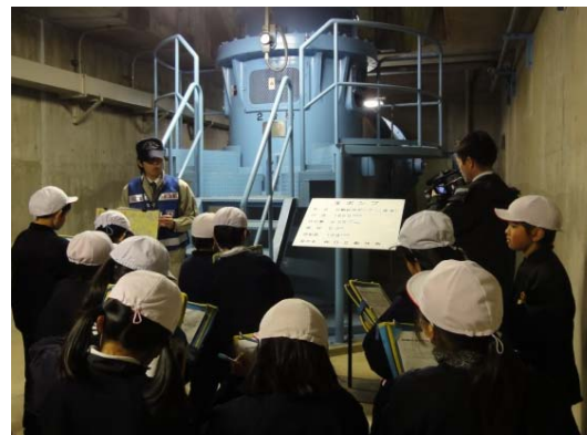
ポンプ室の見学
