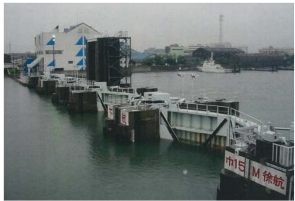
高潮災害に備え、水門・防潮扉の閉鎖
