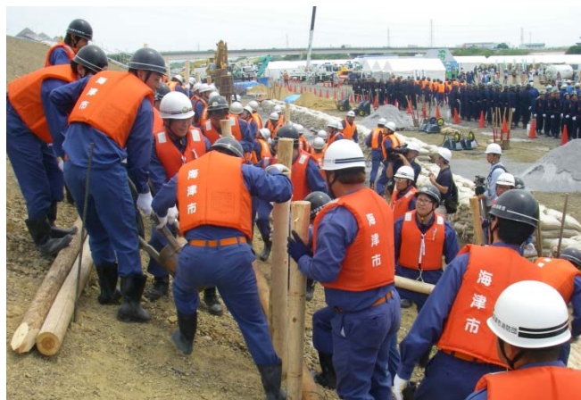
メイン会場 水防工法(杭打ち積み土のう工)
