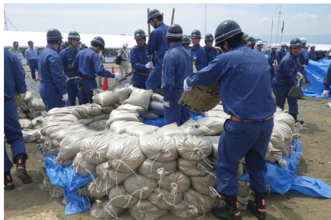
メイン会場 水防工法(釜段工)
