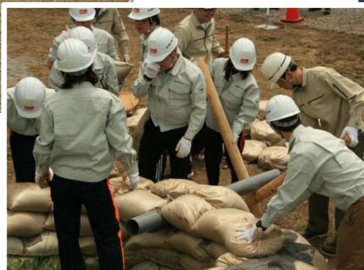
大学生による水防工法の実施(月の輪工)
