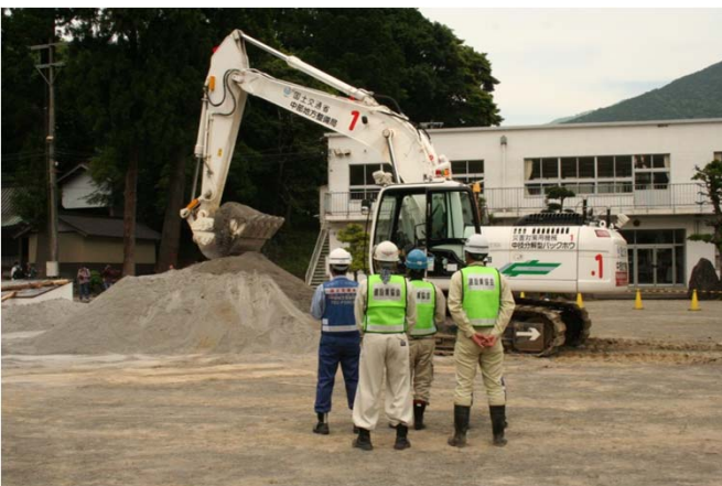
国土交通省分解型遠隔操作式重機による土砂除去
