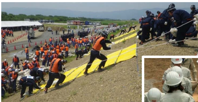
消防団による水防工法の実施(シート張り工)
