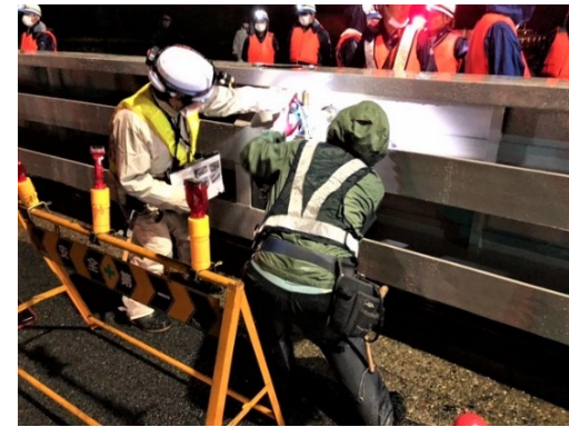
施設点検の様子(右岸側)
