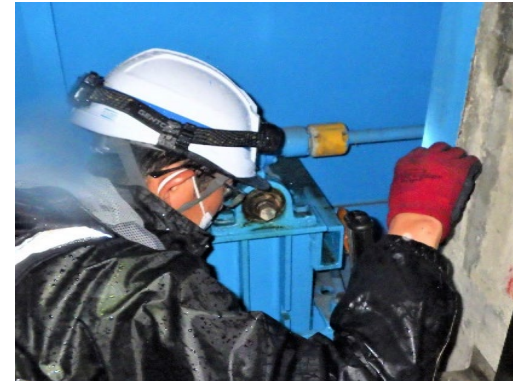
施設点検の様子(左岸側)
