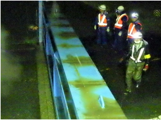
陸閘閉鎖差状況(左岸側)
