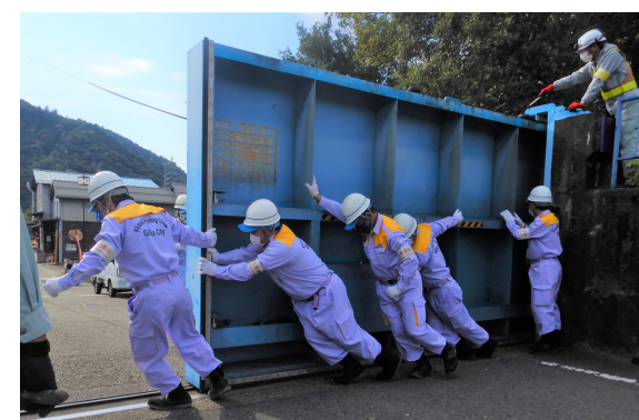
陸閘操作訓練(大前町陸閘)
