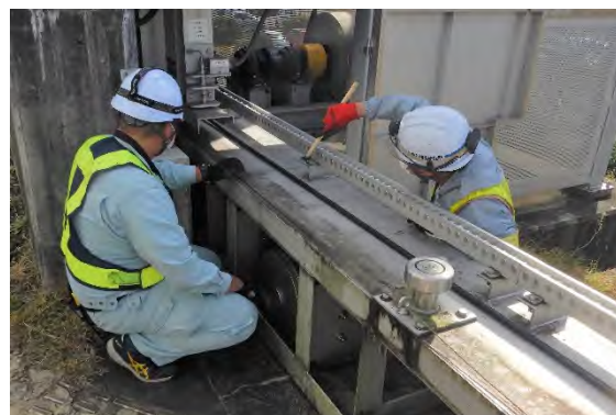
施設点検(築地陸閘)
