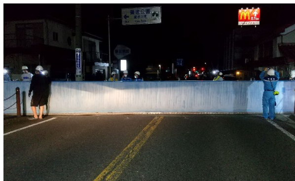
陸閘が完全に閉まった状況(静里町側)
