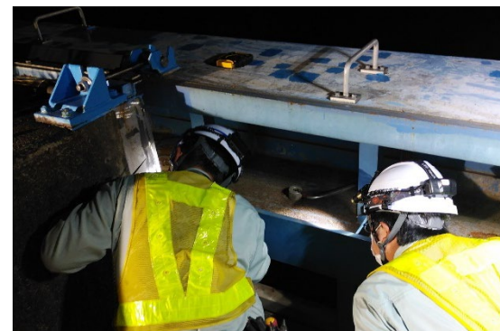
陸閘の設備点検を行う木曽川上流河川事務所
