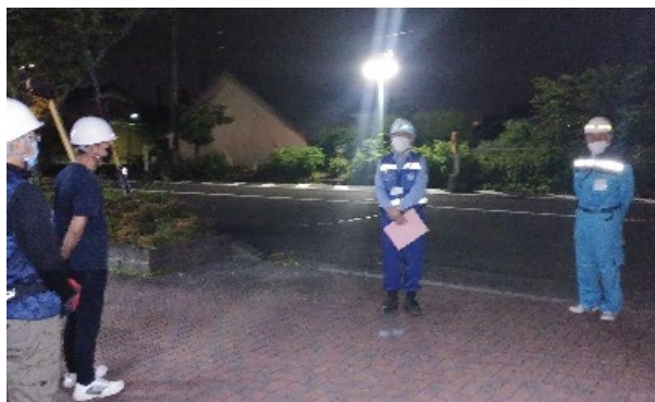
木曽川上流河川事務所及び大垣市役所による 開始前の挨拶
